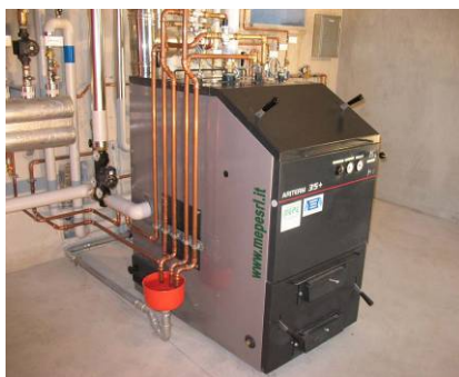
Una scelta lungimirante: la combustione della legna a fiamma rovesciata ad alto rendimento (>90%)
